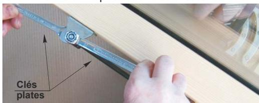
En utilisant les trous pré-perçés, fixer au centre de l'ouvrant la gâche de verrouillage. (2 vis fournies)
