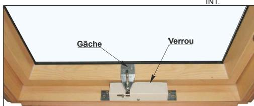
Procéder au raccordement du système de déclenchement du verrou.
